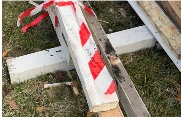
Kuva 11: Pilotissa käytetty merkintätapa(huomionauha johon kirjoitettu julkisivun sekä nipun numero)
