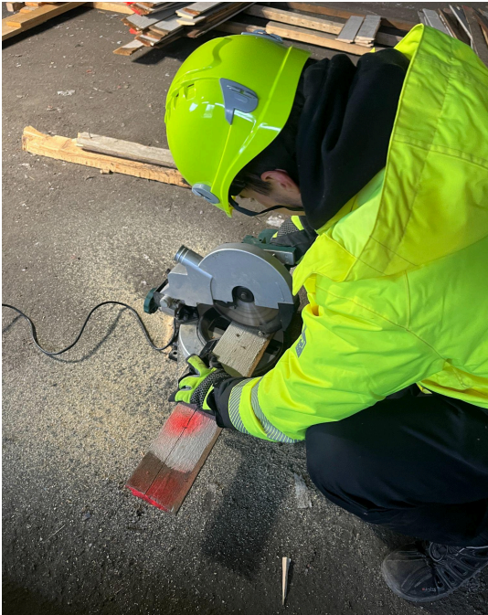
Kuvat 14 ja 15: Kierrätykseen kelpaavan materiaalin jatkokäsittelyä (sirkkelöintiä ja nauhojen poistoa)
