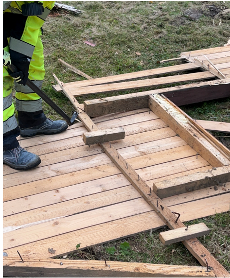
Kuva 10: Purku ja lajittelu maassa.
