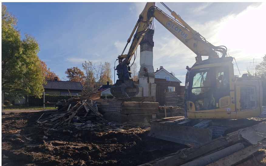
Kuva 12: Hirsien irrottamista.
