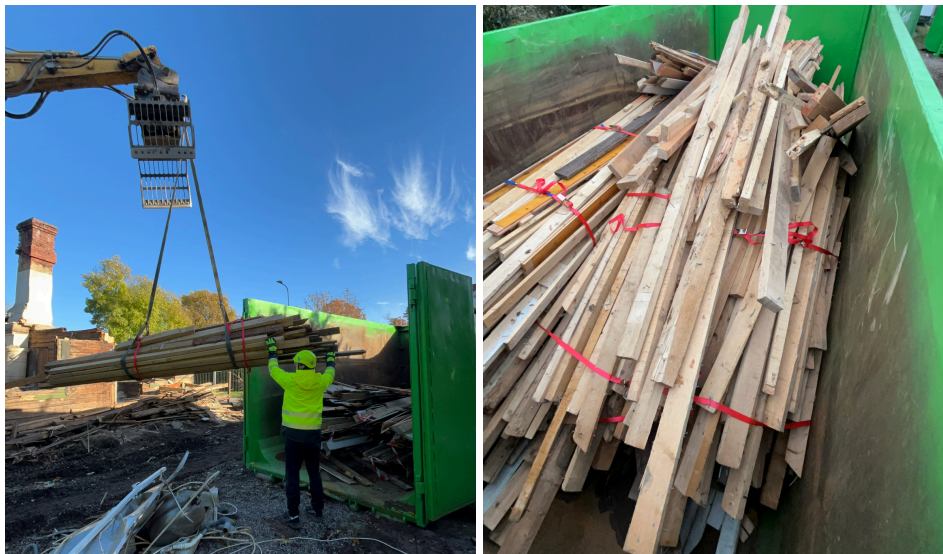
Kuvat 12 ja 13: Nippujen siirtäminen kuljetukseen lavalle.
