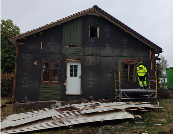
Kuva 7: Ulompi ulkoverho (valkoinen) purettuna maahan
