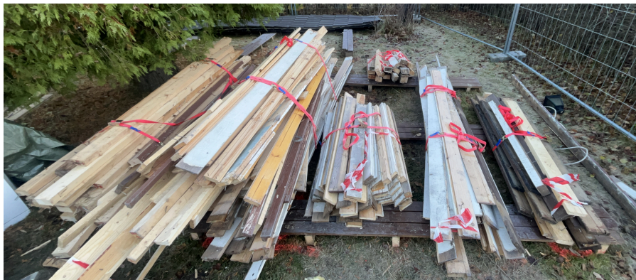
Kuva 9: Lajiteltu kierrätyspuu julkisivusta 3 valmiina kuljetusta varten.
