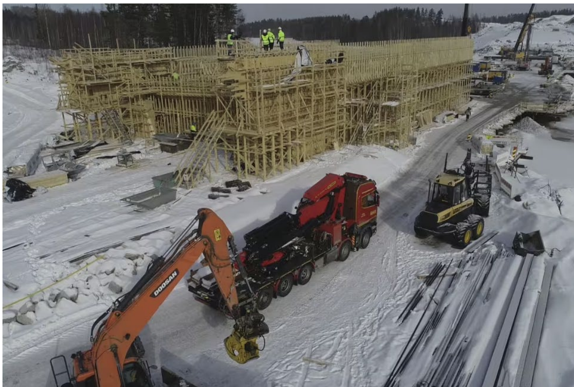
Kuva 8. Tärntämäen 220 metriä pitkän sillan rakentaminen Äänekoskella 2018. Kuva YLE Jeremias Perätalo
